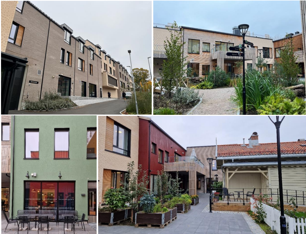
Figur 51 Døme på kombinasjon av tre, tegl og pussa fasadar frå Dronning Ingrids Hage, Oslo kommune.
